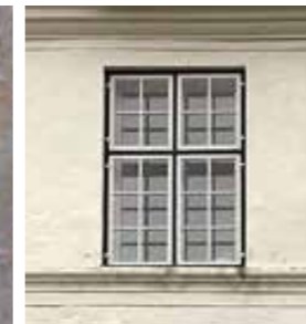
Ein Kalkanstrich braucht keine Biozide und ist diffusionsoffen.
