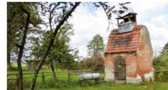
Ehemaliges Trafohaus der Landsdorfer Gutsanlage im Jahr 2012.
