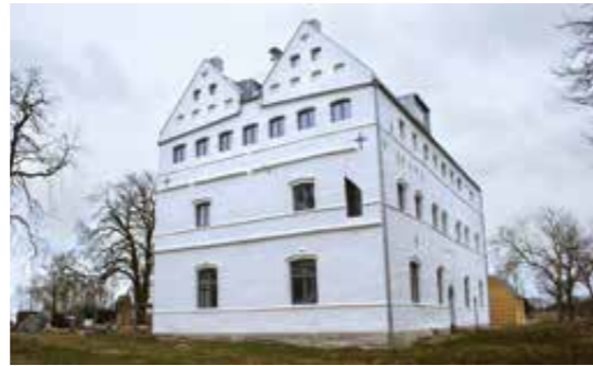
2018 wurde der Wiederaufbau des Herrenhauses und die Restauration der noch erhaltenen Bausubstanz abgeschlossen.
