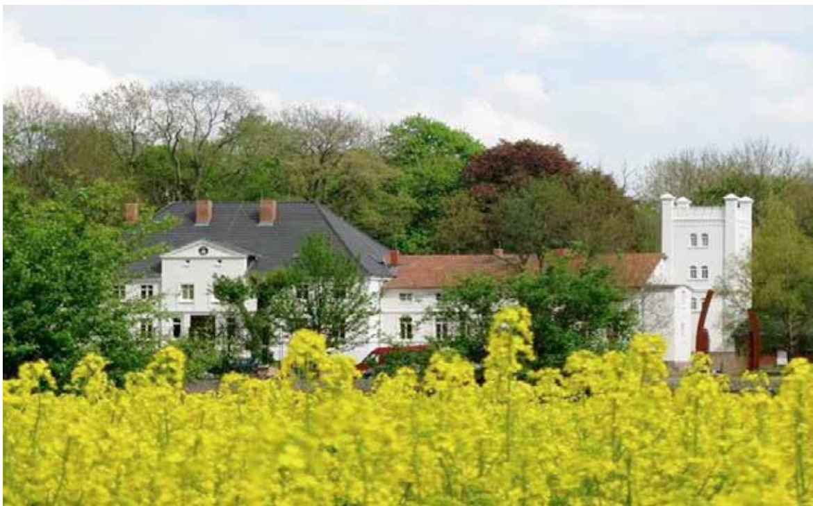
Bild 2: Das sanierte Gutshaus (Foto: Peter Legemann)
