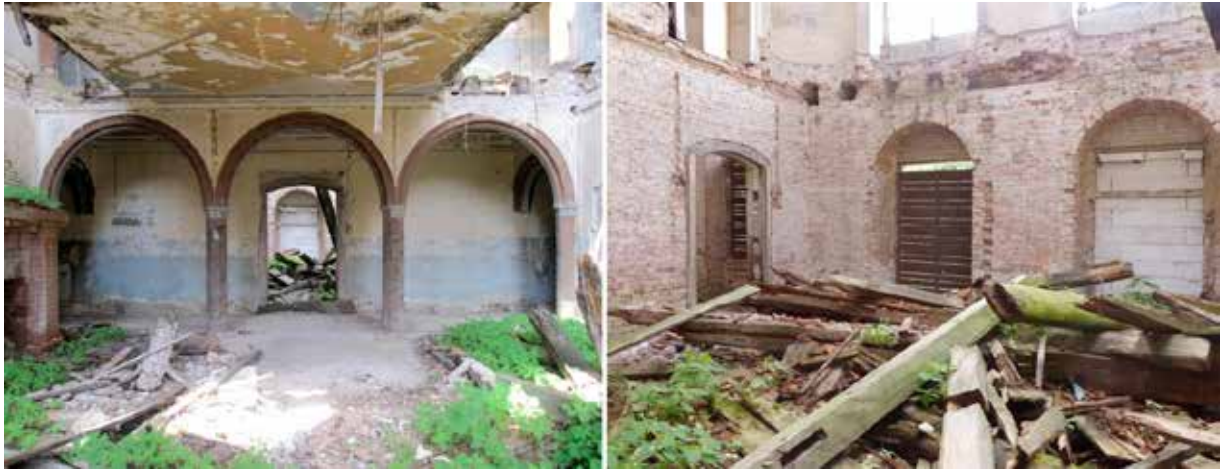
Abb. 05: Schloss Broock, Eingangshalle/ Gartensaal, 2014
