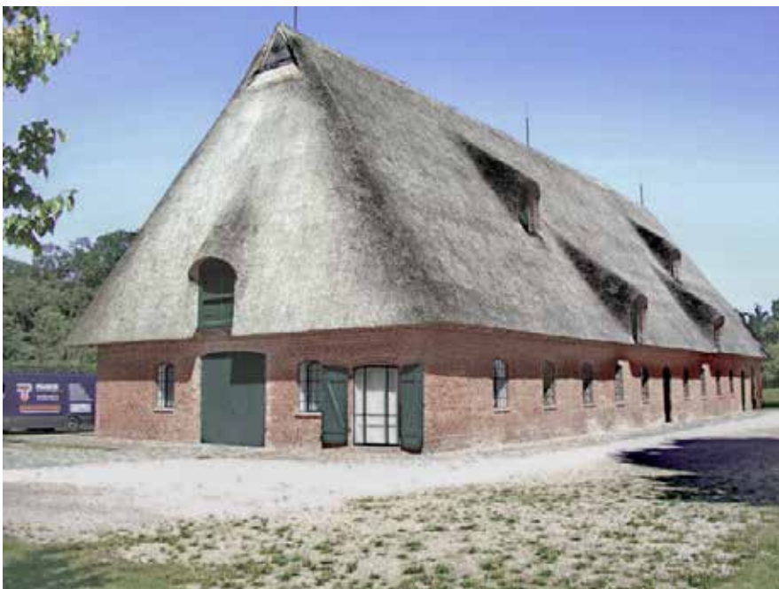
Abb. 13: Gut Weissenhaus, Jungviehstall saniert
