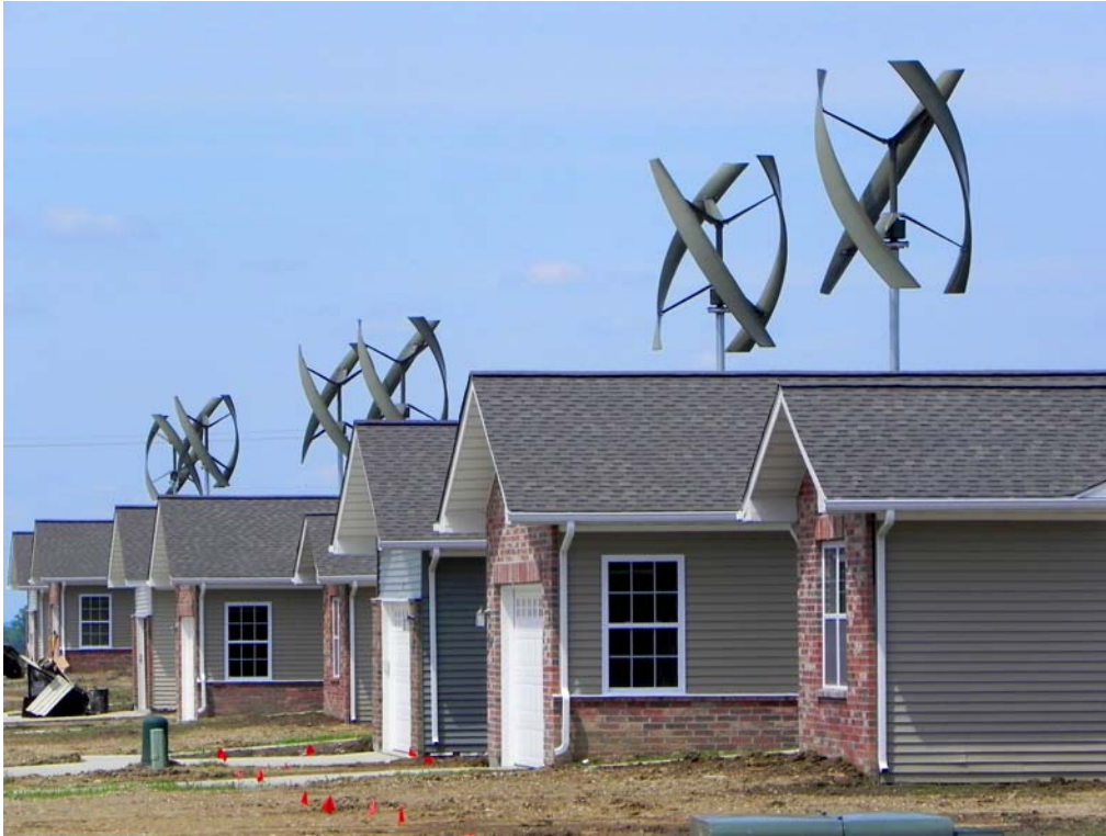
Abb. 6-2: UGE WindTurbine eddyGT mit einer Nennleistung von 1 kW 47
