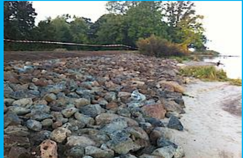
Reparatur Deich Warthe nach Hochwasser
